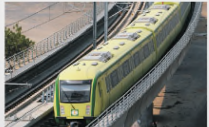
Al Mashaaer Metro, KSA
